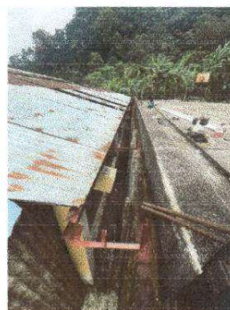
Foto 2: Reparación de canales.
