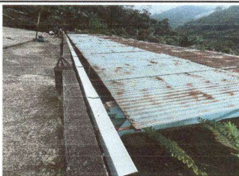
Foto 5: Colocación de canal.
