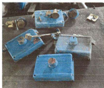
Foto 4: Sustitución de chapas.
