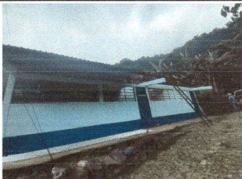
Foto1: Desmontar lamina modulo 2.
