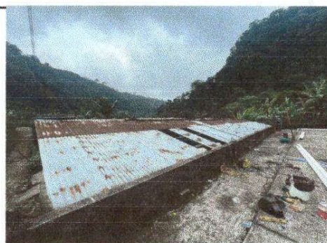
Foto 6: Desmontaje de lámina modulo 1
